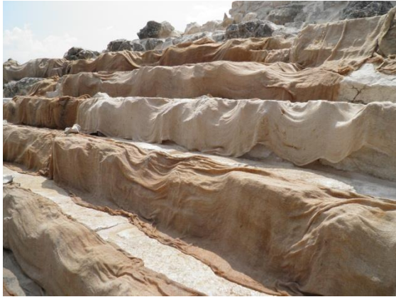
Resim 3: Harcın prizlenme süresi boyunca nemli tutulması için keten bezi kullanılmıştır.
